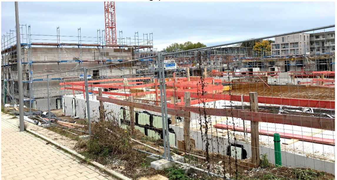
Abbildung 9: Baufortschritt im sogenannten Trapezblock, Stand Oktober 2024, im Hintergrund das fertiggestellte Gebäude auf dem sogenannten Pioniergrundstück an der Immanuel-Kant-Straße (Quelle: NRW.URBAN)
